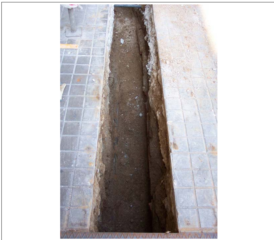
Foto 30: Cinquè tram del carrer Pelai, 32
