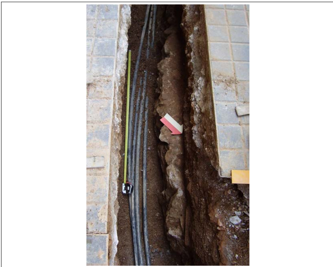
Foto 32: Estructura UE 120 al carrer Pelai, 34, 36
