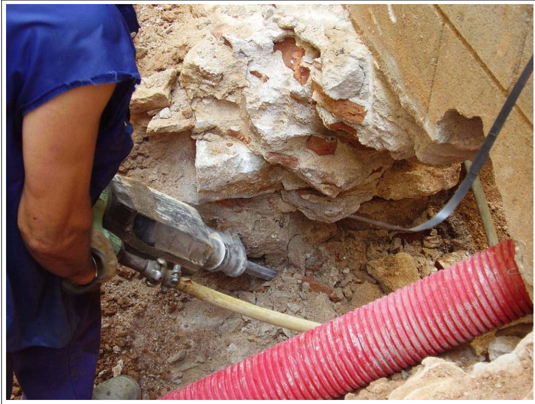
Foto 54: Demolició de l'antiga línia de façana UE 121
