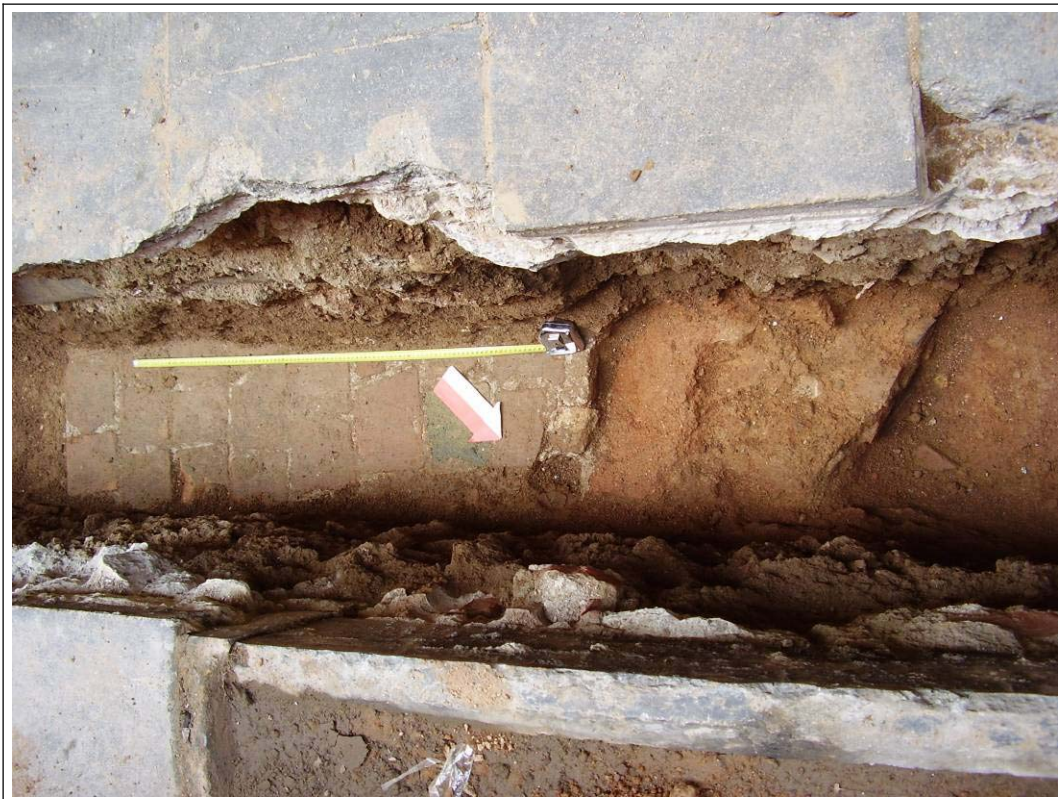
Foto20: Detall del mur UE 116 afectat pel paviment UE 115
