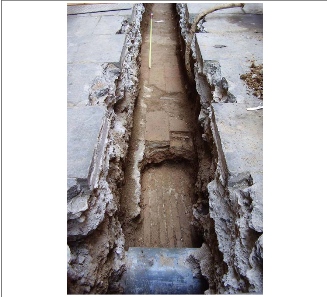
Foto 17: Estructura UE 113 i paviment superposat UE 114
