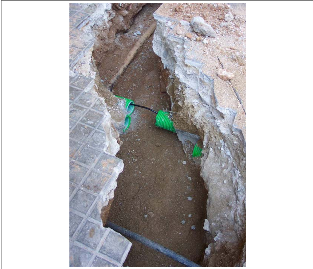
Foto 31: Tram final de la rasa al carrer Pelai, 30
