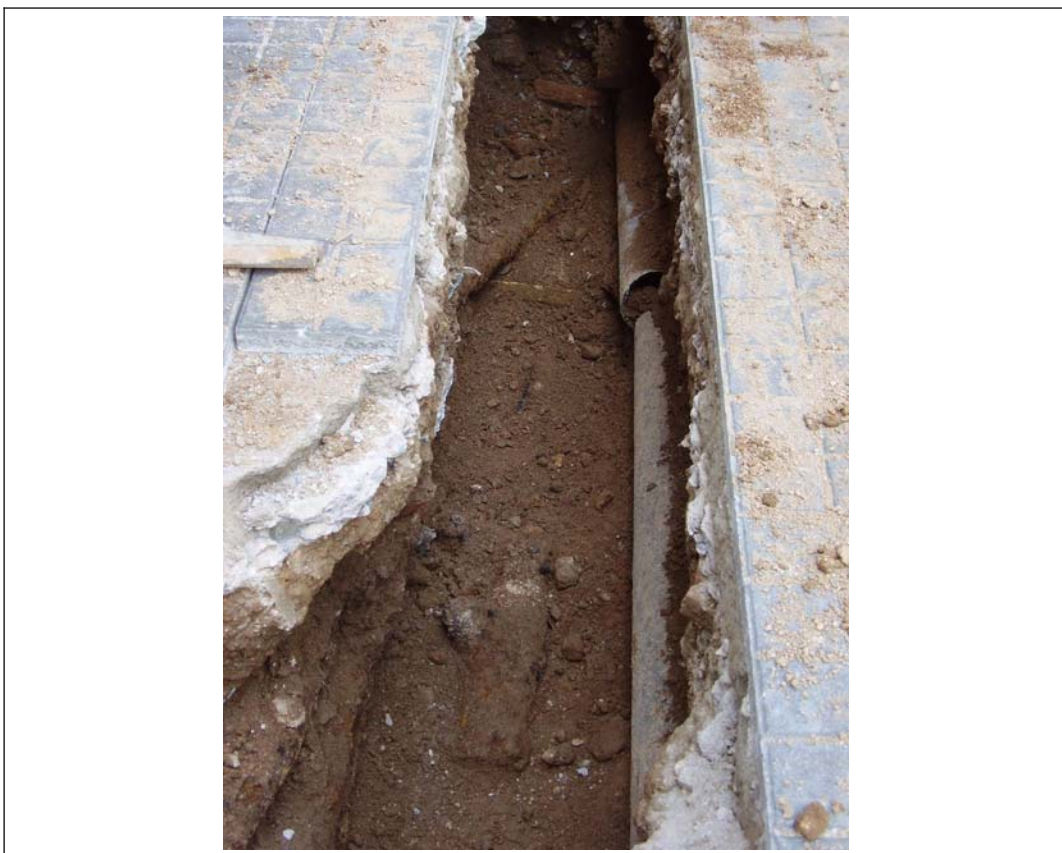
Foto 26: Detall de la rasa al primer tram del carrer Pelai, 40
